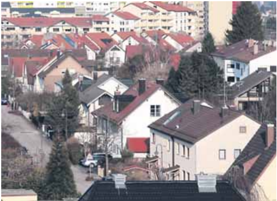
Alte Häuser, wie hier in Germering, gibt es in Deutschland viele. Es ist sinnvoll, diese Gebäude aus den 50er bis 70er Jahren energetisch zu sanieren. Denn der finanzielle Aufwand lohnt sich auf lange Sicht.
